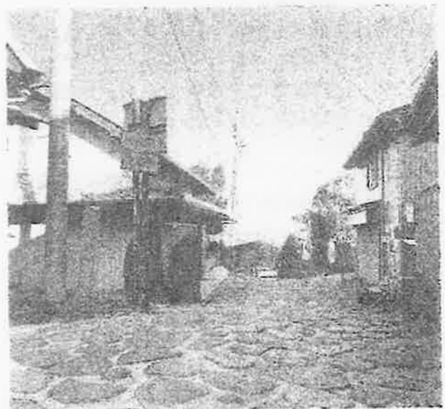
大阪府と奈良県の境となる暗峠付近の国道308号には石畳が残る
