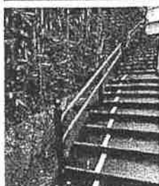
階段手すり延伸設置 (東石切町)
