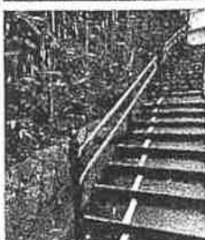
階段手すり延伸設置 (東石切町)
