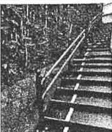
階段手すり延伸設置 (東石切町)
