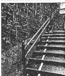
階段手すり延伸設置 (東石切町)
