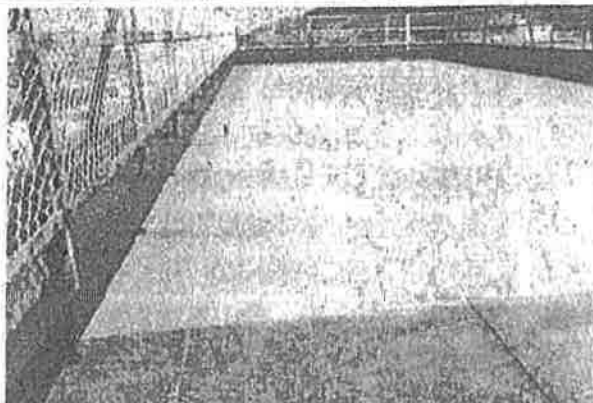
◆上・孔舎衛東小の屋上防水工事。1/3しかできず、未工事カ所は雨漏り。◆中央・どこの学校もまだ多い和式トイレ。 ◆下・石切東小の校舎内の天井、ろう下の窓枠サッシ部の雨漏りのシミ(※写真は昨年調査時)
