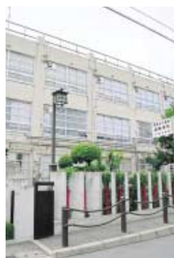
子どもたちの安全を守るためにも、学校施設の計画的な耐震化が急がれます。(市内小学校)
