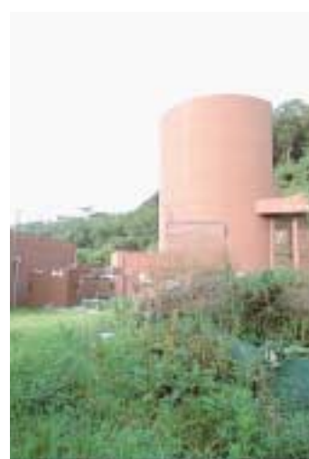
生駒山ろくにある中央換気塔に排気ガス対策として浄化装置の設置は協定書によって約束されています。
