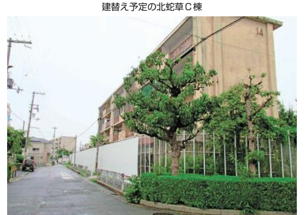
建替え予定の北蛇草C棟
