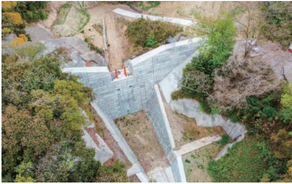
「生駒山の砂防堰堤（大阪府八尾土木事務所提供）」
