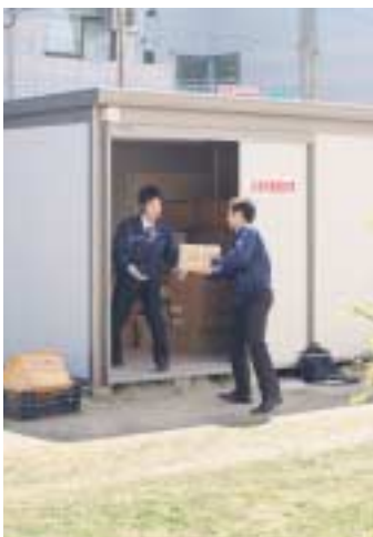
大地震等の災害対策として備蓄倉庫を校庭等に整備しています (八戸ノ里東小学校)
