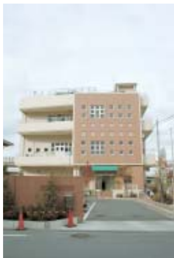
市長公約である中学校給食実現の財源を示すことが求められています。(弥生給食センター)
