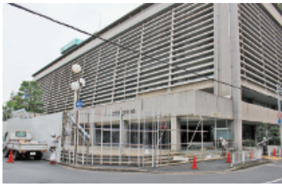
代替施設もなく解体が進む市民会館
