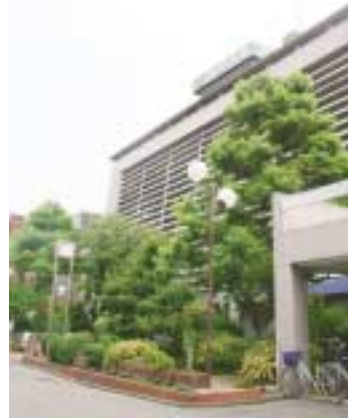
利用ニーズからも閉館後の代替施設 をどうするか問われる市民会館
